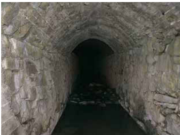
Le canal de fuite, vue en 2006 avant sa reprise en béton vers 2008.
