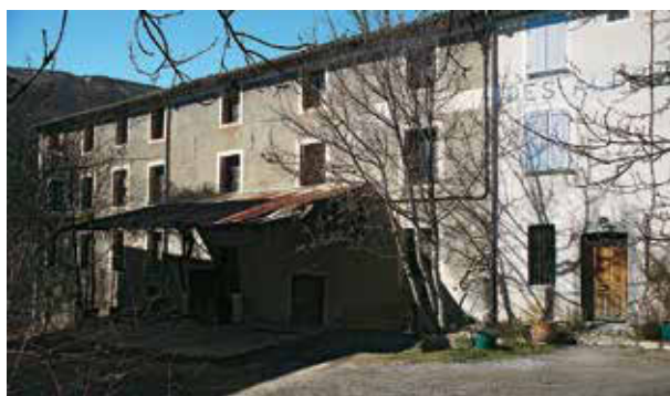
La minoterie Dol vue au début du 20 e siècle et en 2014. On distingue bien la différence de largeur des travées entre l'extrémité du bâtiment et la partie centrale où se trouvent les mécanismes.
