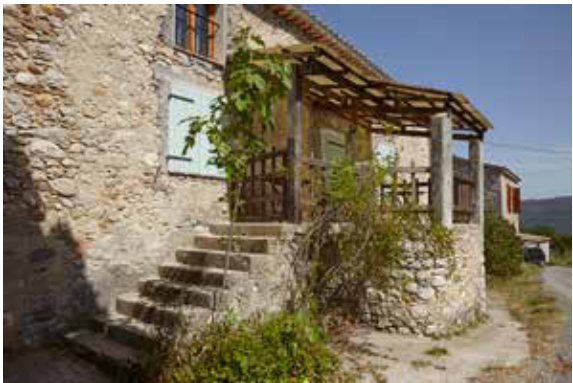
Escalier extérieur se prolongeant par un repos couvert d'un appentis sur piliers à Saint-Pierre.
