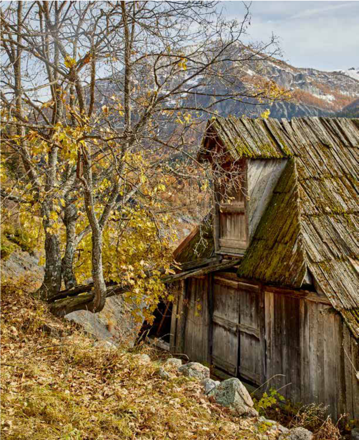
Réduit clôt de planches à l'entrée d'une coursière à Villard Bas (Allos). Le garde-corps de l'escalier remploie un barreaudage de crèche à bovins.
