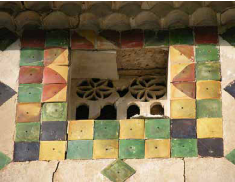
Baie de pigeonnier à la Lagne (Castellane). Carreaux monochromes rouges, grille d'envol en bois percée de motifs en cœurs, cercles et une étoile.
