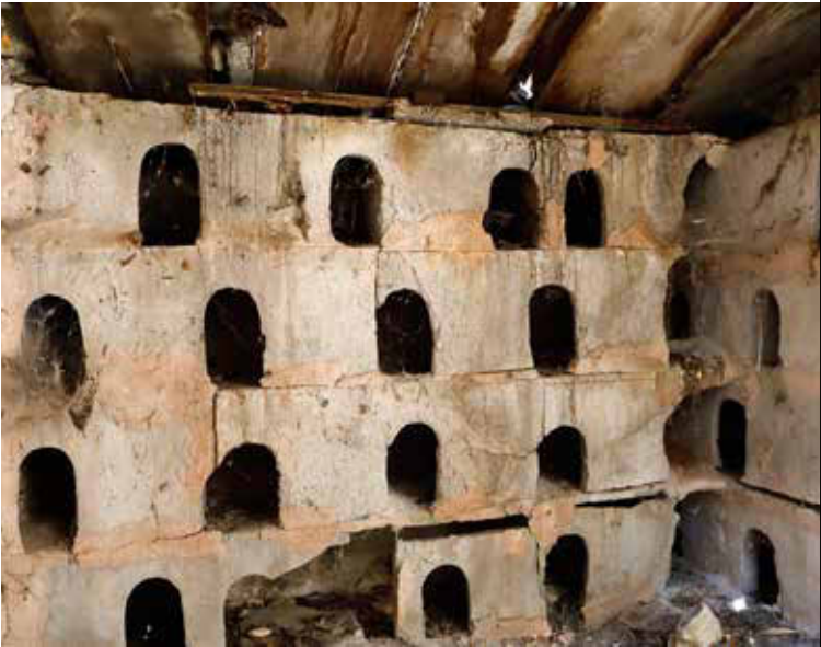
Boulins maçonnés dans un colombier à Rougon.
